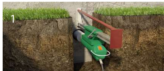
Алмазное сверление фундамента для прокладки канализационного трубопровода.
